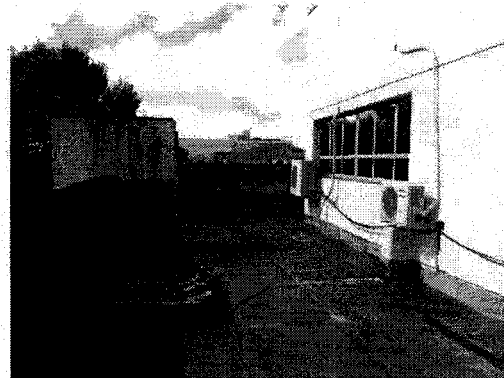
Foto 24: Laje descoberta do plenário deve-se fazer a impermeabilização com manta asfáltica ou cobrir tal laje
