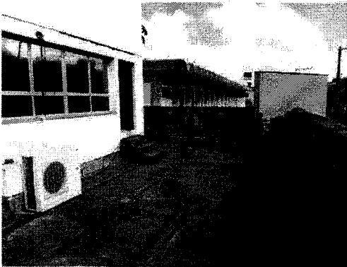
Foto 23: Laje descoberta do plenário deve-se fazer a impermeabilização com manta asfáltica ou cobrir tal laje
